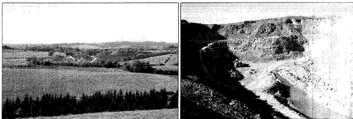
La carrière de roche massive de « Chassang » à Saint-Poncy et son environnement morphologique
