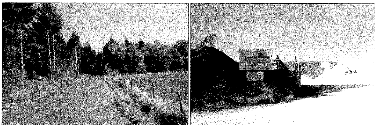
Accès par les RD310 et RD123 à la carrière de roche massive de « Chassang » à Saint-Poncy
